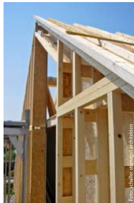
Holzbau mit genügend Platz, um Zellulose einzublasen.
